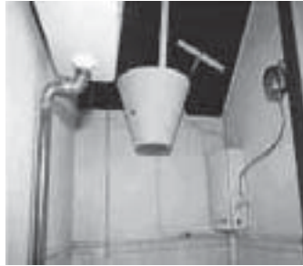
FIGURA 2. No banheiro, de sua casa de Petrópolis, Santos Dumont fez um chuveiro de água quente tendo o álcool por combustível. O calor da chama faz a água entrar em ebulição, subindo para um balde que possui duas alavancas: uma para misturar a água quente com a fria e outra para abrir o fundo de um balde, perfurado como regador de plantas. Assim, ele podia repetir o movimento quantas vezes julgasse necessário, tornando a ducha aquecida, um luxo inédito para a época. (Adaptado de http://novaescola.abril.com.br/index.htm )
